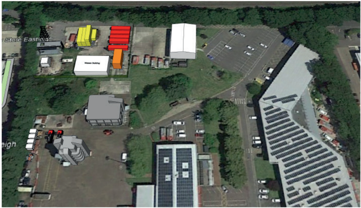
HIWFRS Live Fire - Existing Site
