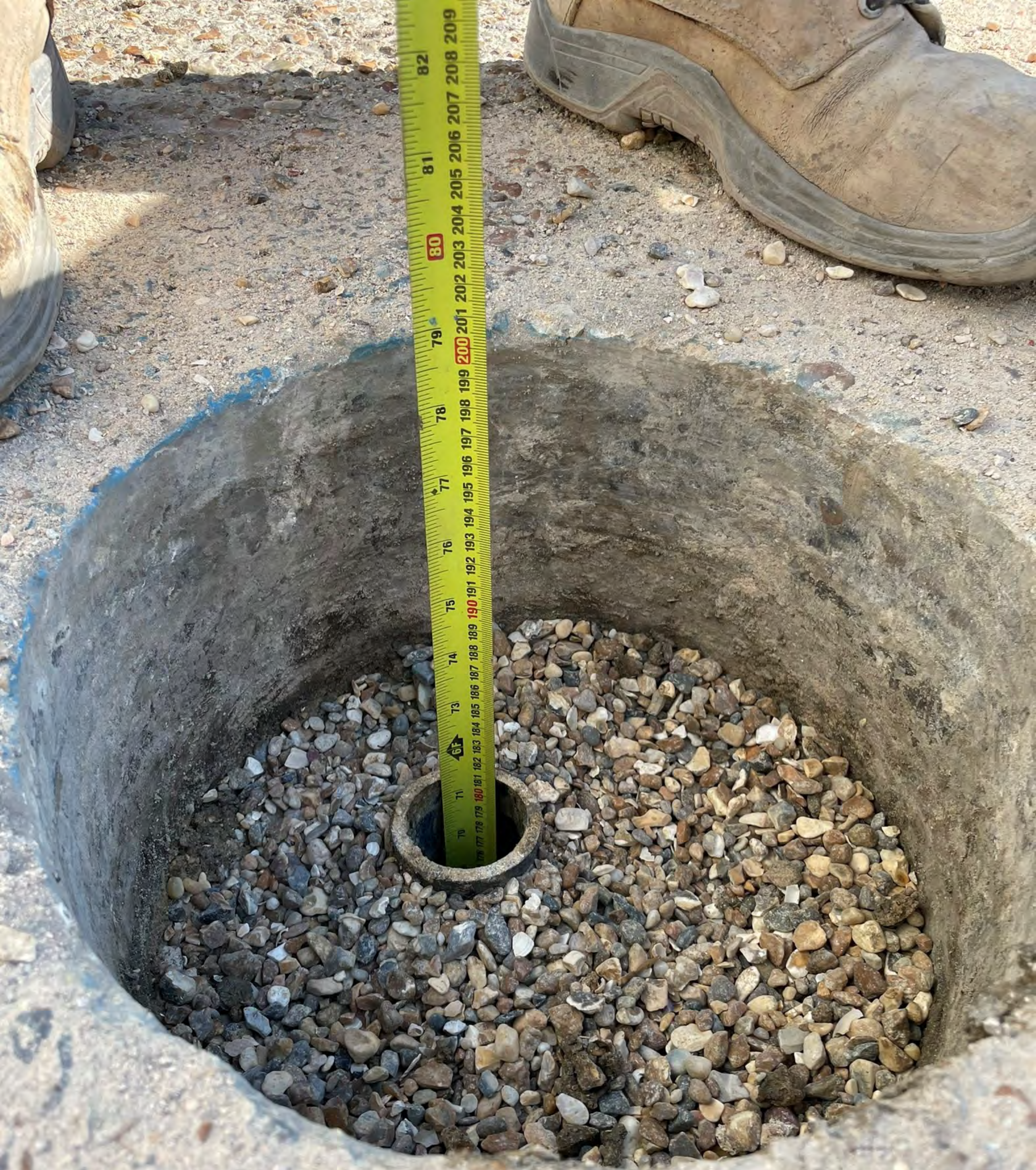
DS132 Shingle Fill 2m Below
