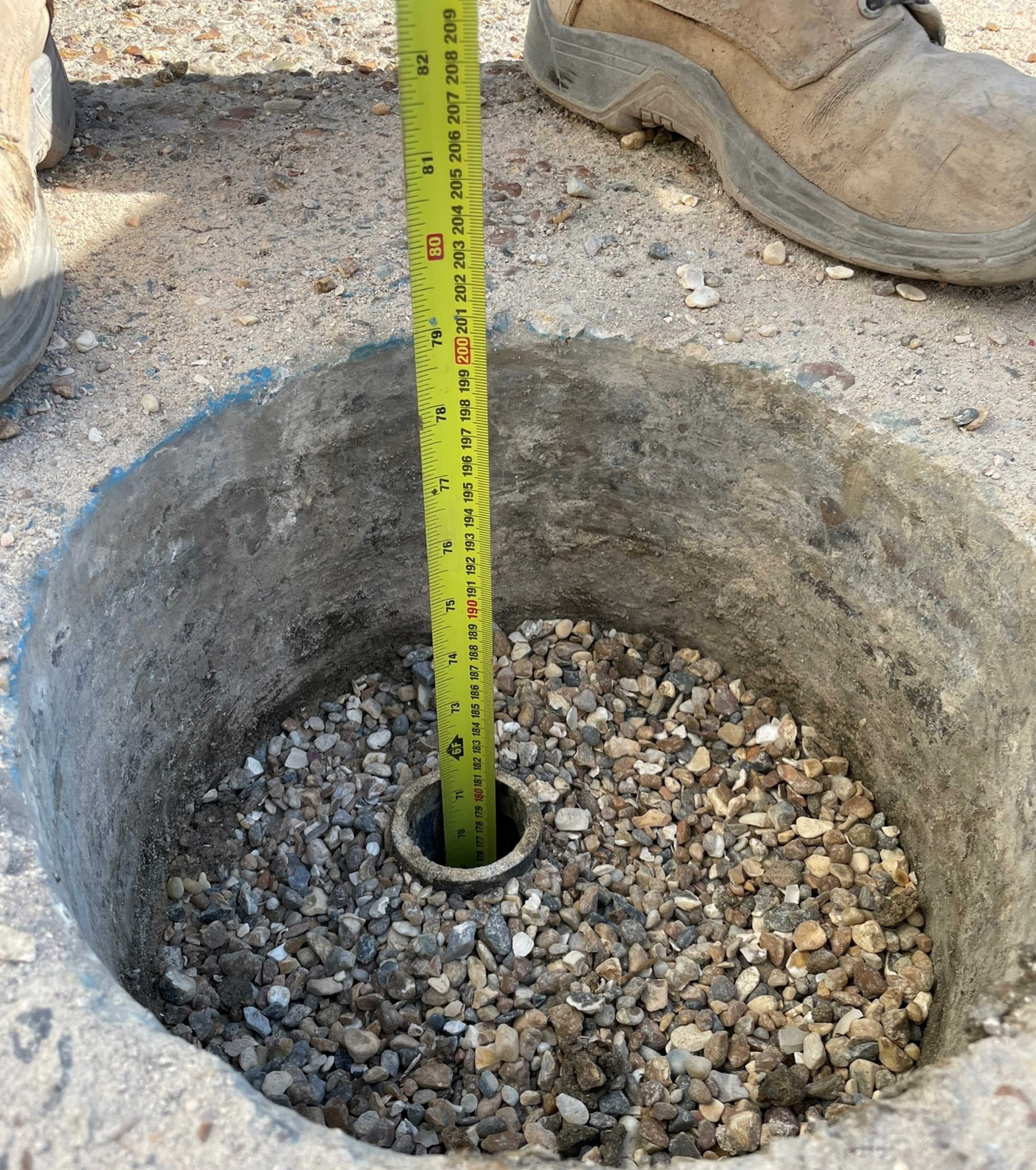
DS132 Shingle Fill 2m Below
