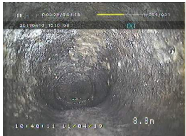
Photo: 9_9_69_A.JPG 8.8m, Manhole
