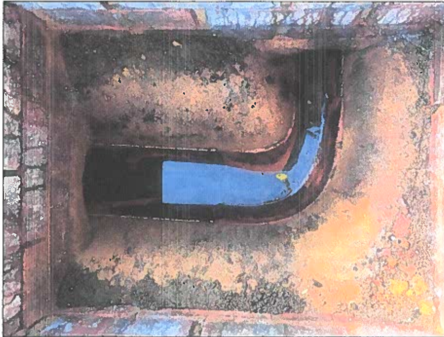
Photo: CABIN MH 2.JPG
