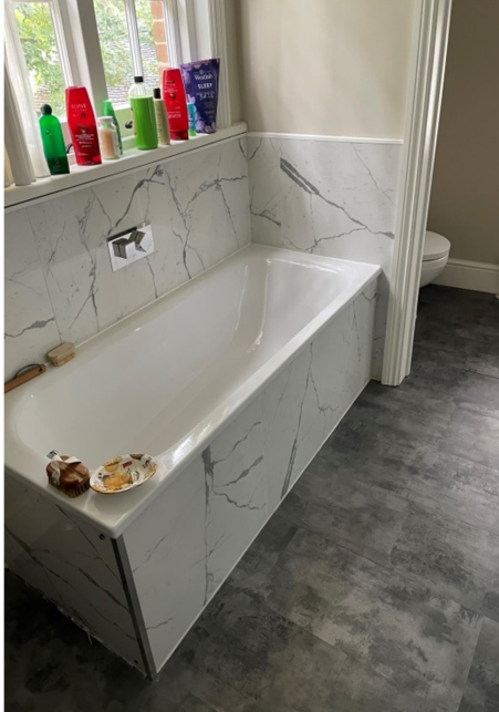
Remove sanitaryware, remove wc door & side wall
