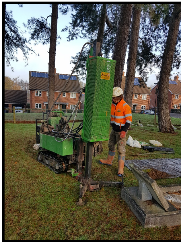
Plate 2: Mini piling rig.
