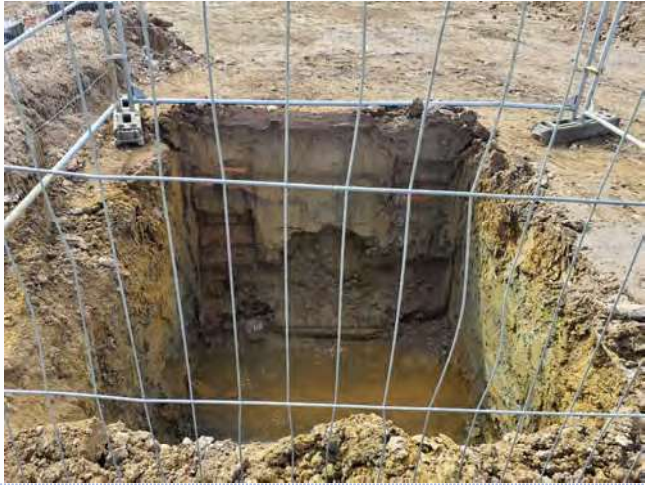
DescriptionArea C tank
